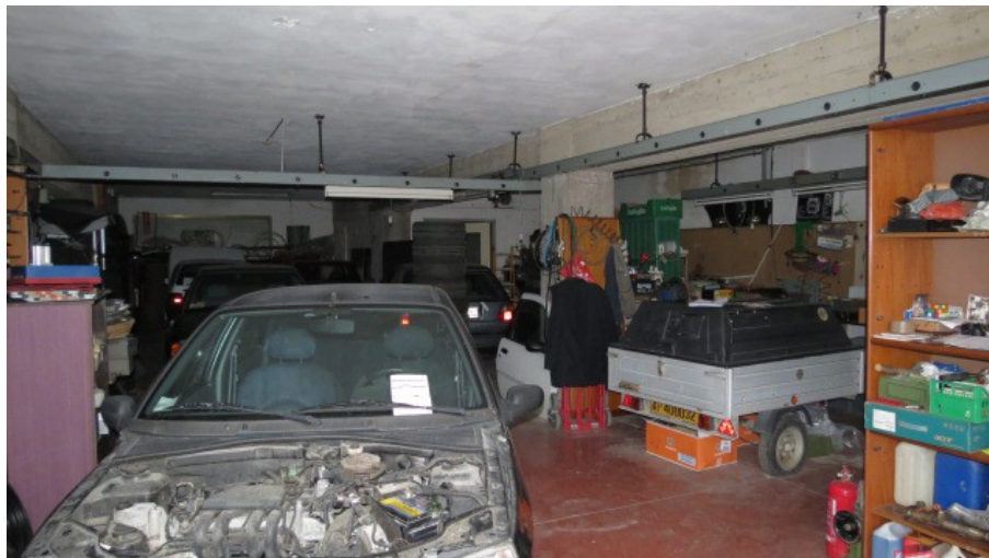
VISTA INTERNA PORZIONE PIANO SECONDO SOTTOSTRADA
