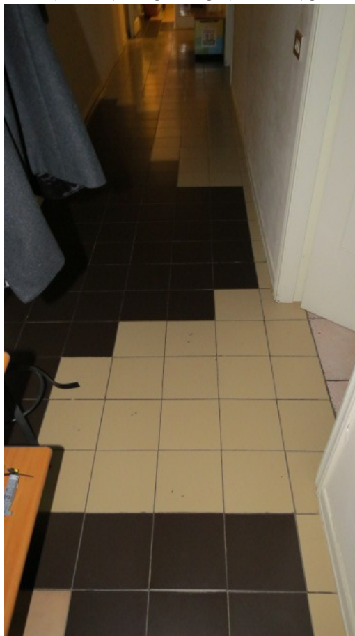
VISTA INTERNA PORZIONE PIANO PRIMO
