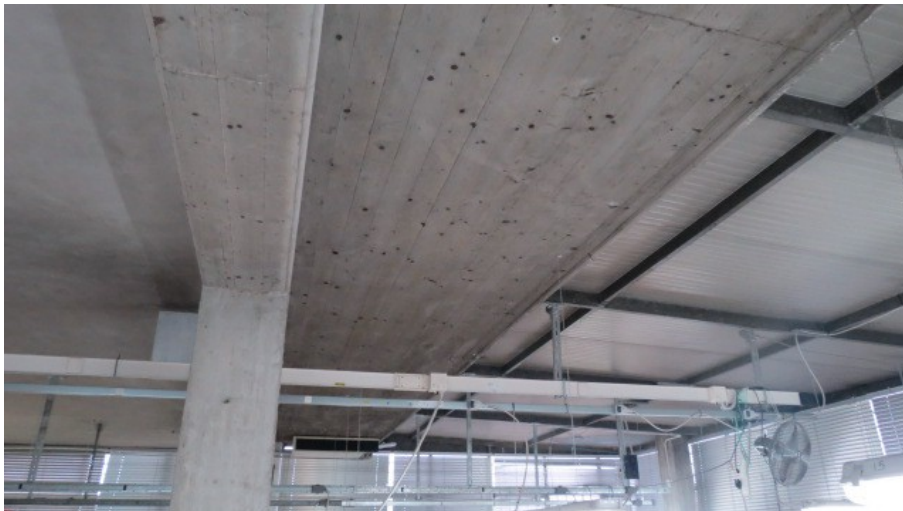
VISTA INTERNA PORZIONE PIANO SECONDO SOTTOSTRADA
