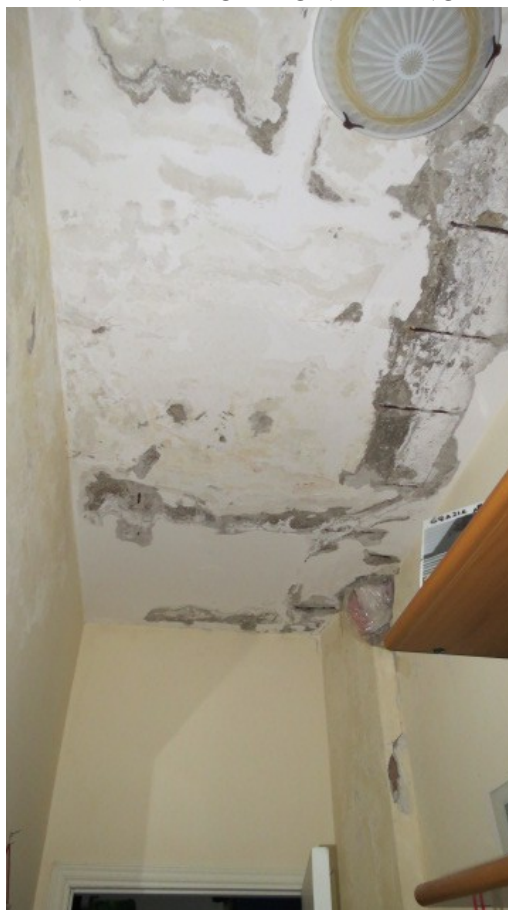
VISTA INTERNA PORZIONE PIANO PRIMO
