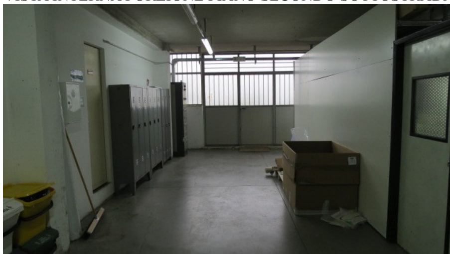
VISTA INTERNA PORZIONE PIANO SECONDO SOTTOSTRADA
